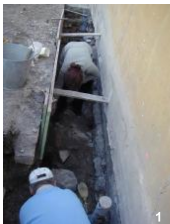
Foto 1 – V rámci statického zajištění bylo provedeno ztužení celého objektu v úrovni stropních konstrukcí ocelovými předepnutými lany, provádí se výkopy pro železobetonové obrubní pasy kolem západní části budovy.
