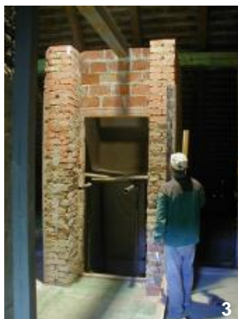
Foto 3 – Také šachta výtahu je již stavebně připravena pro jeho montáž.
